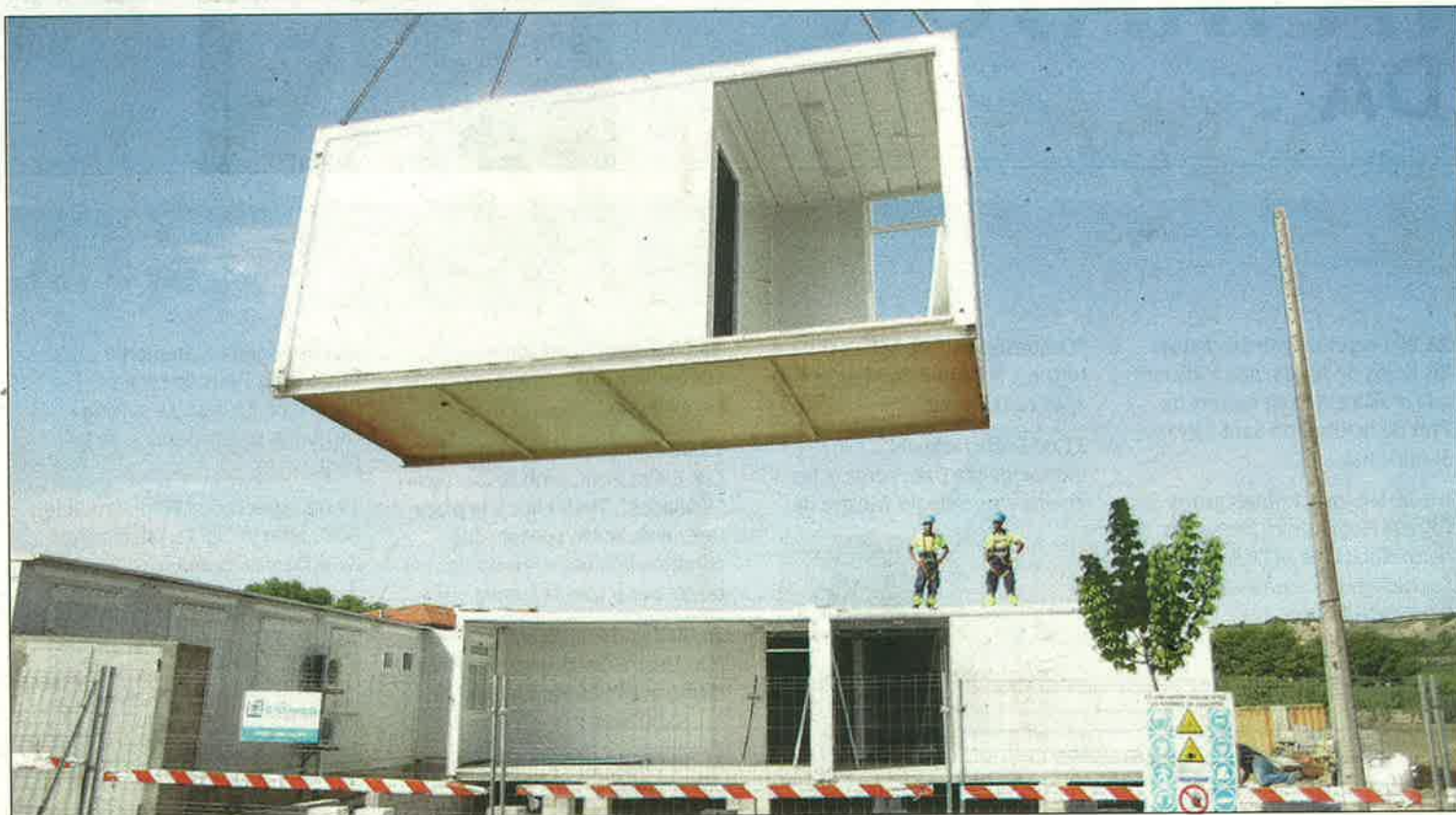
FOTO: Tony Alcántara / Després de la col·locació dels mòduls es procedirà a les pertinents adequacions elèctriques i de clavegueram
