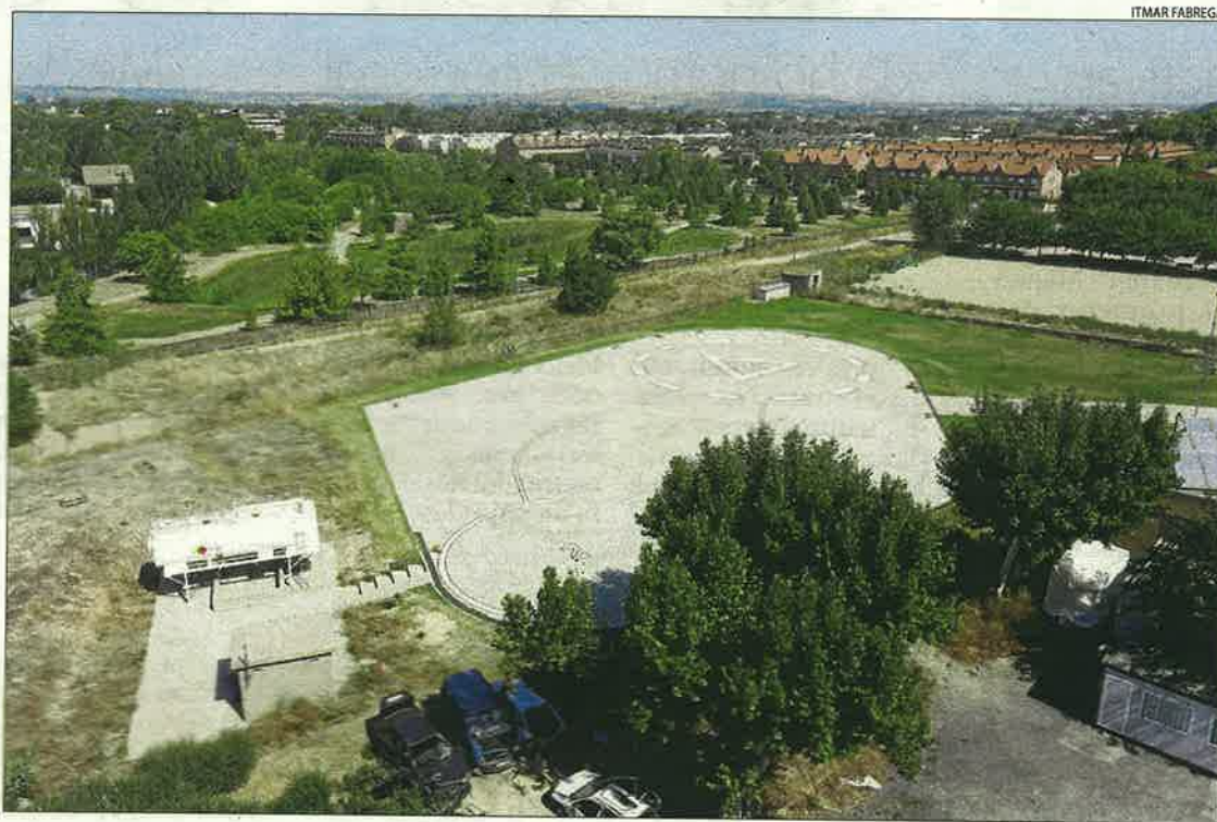
Vista de l'actual heliport, just al costat del parc de bombers, a menys d'un quilòmetre de l'hospital.
