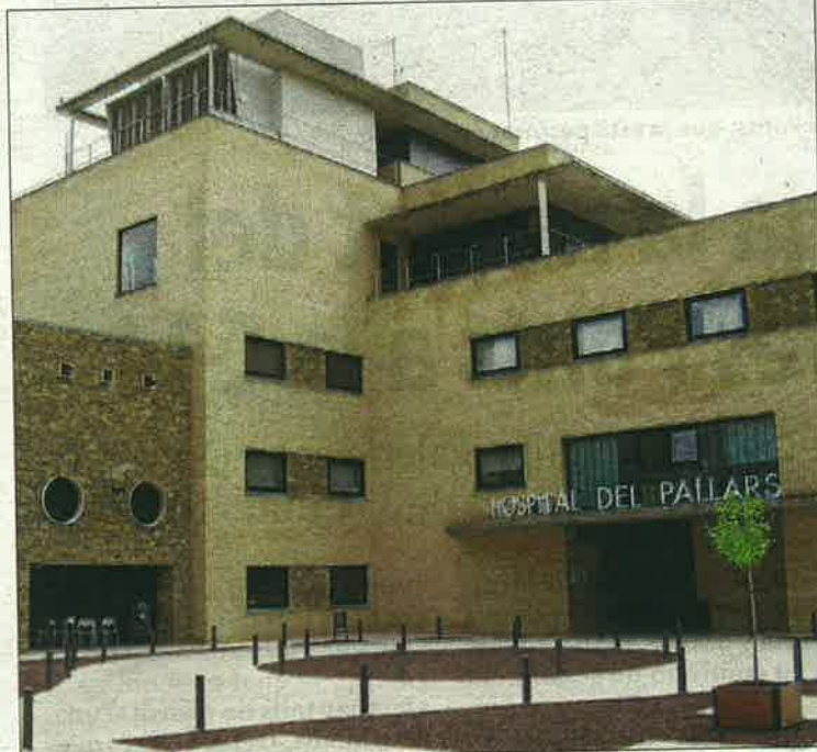
Imatge d'arxiu de la façana de l'hospital del Pallars, a Tremp.
