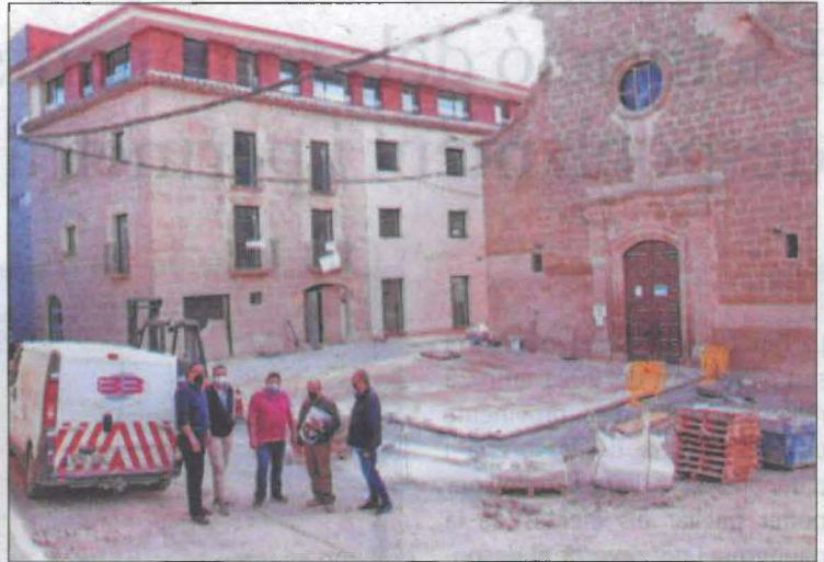
FOTO: Aj. Alpicat/ L'alcalde i el tinent d'alcalde durant la visita a les obres
