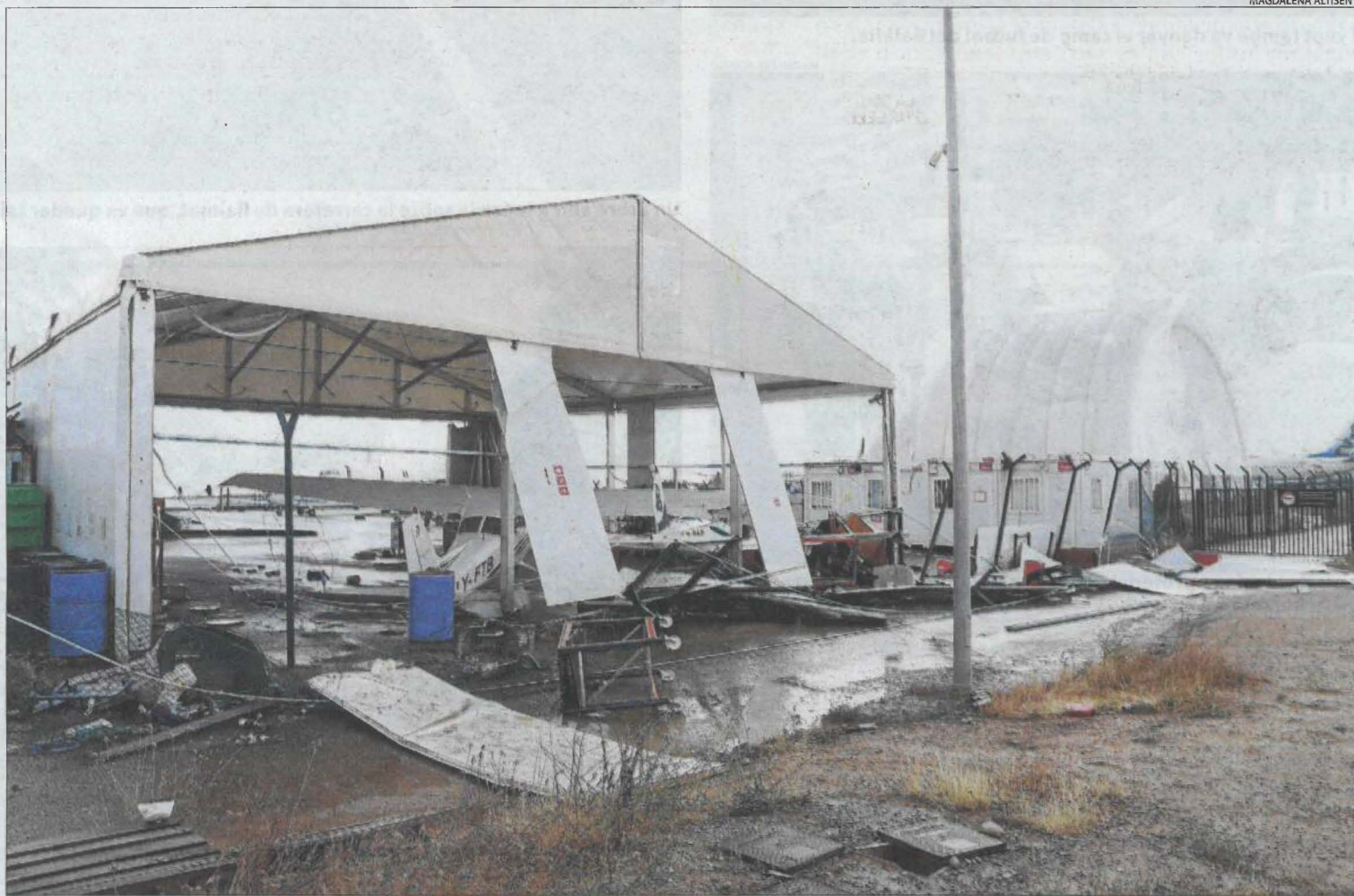
El vent va fuetejar l'aeroport d'Alguaire, va arrancar mòduls prefabricats i fins i tot va destrossar part d'un hangar inflable.
