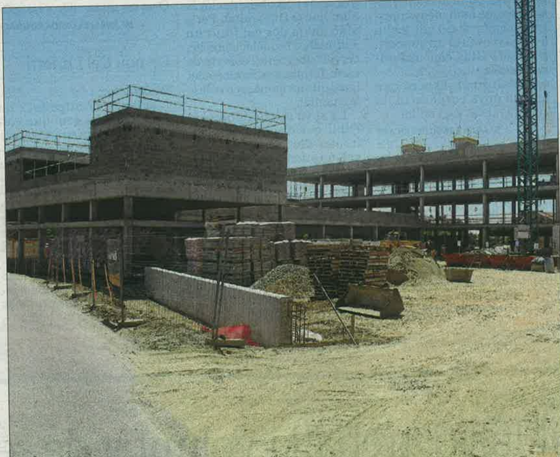
L'Institut de Torrefarrera ja s'està construint i substituirà els barracons el març que ve.
