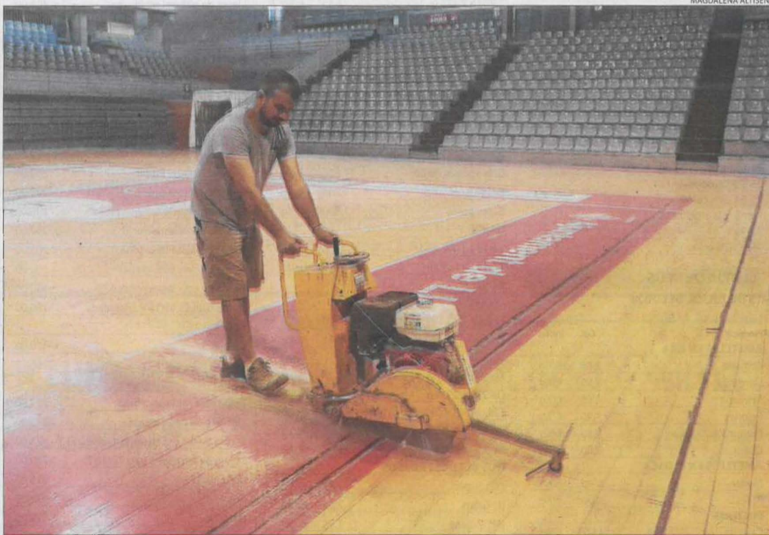
Un operari de l'empresa contractada, ahir tallant els panells de fusta abans de retirar-los.
