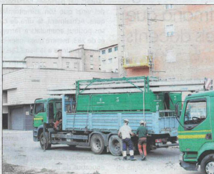
FOTO: T.A./ El servei de manteniment retirant la carpa instal·lada
