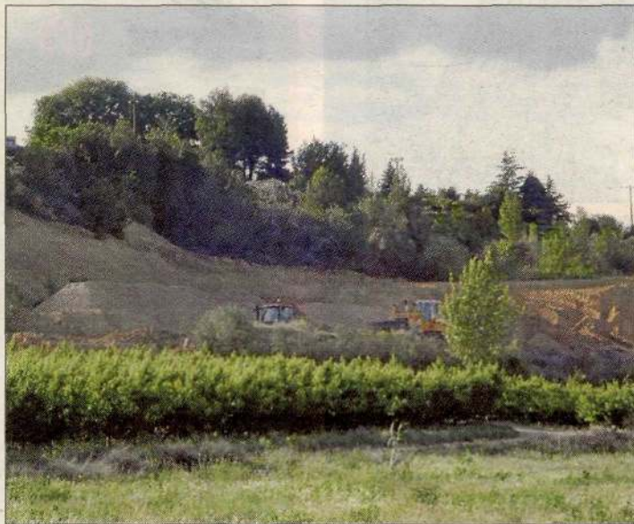
La zona protegida a la Casilla on s'estan remouvent terres.
