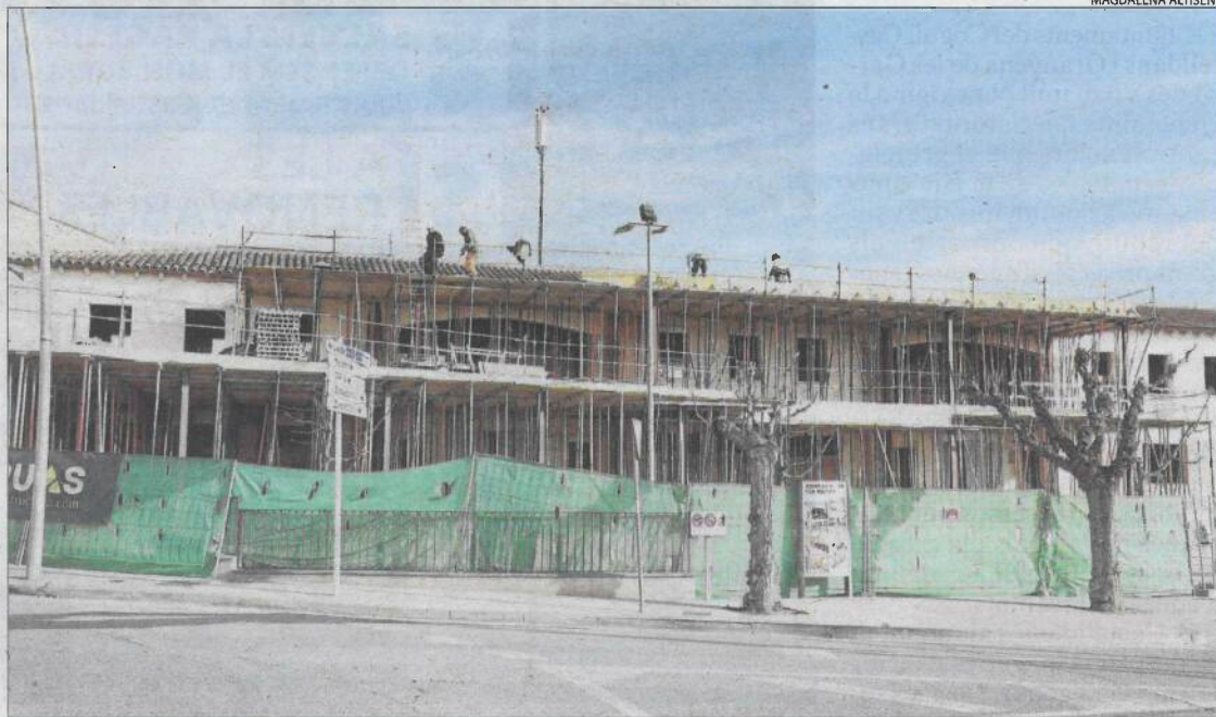
Les obres de reforma de la biblioteca, on s'habilitarà més espai fins a sumar 1.150 metres.
