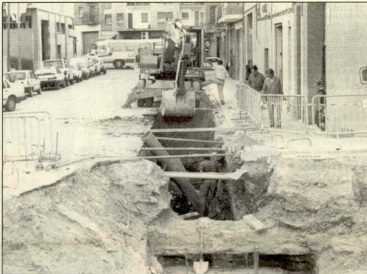
Les obres de la primera fase del col·lector del Noguerola estan molt avançades.
