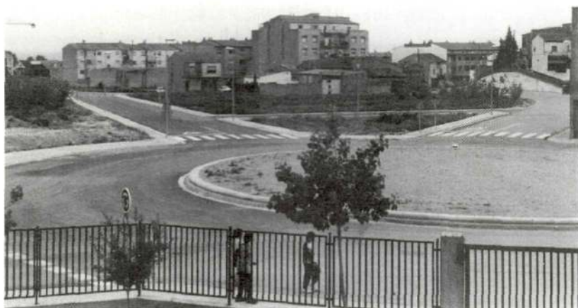
Obres d'urbanització del carrer del Nord.
