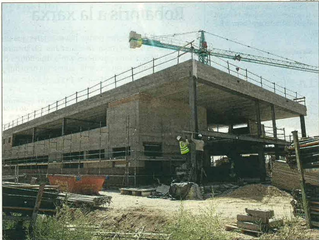
La construcció de l'edifici per a primària al col·legi Parc del Saladar d'Alcarràs.
