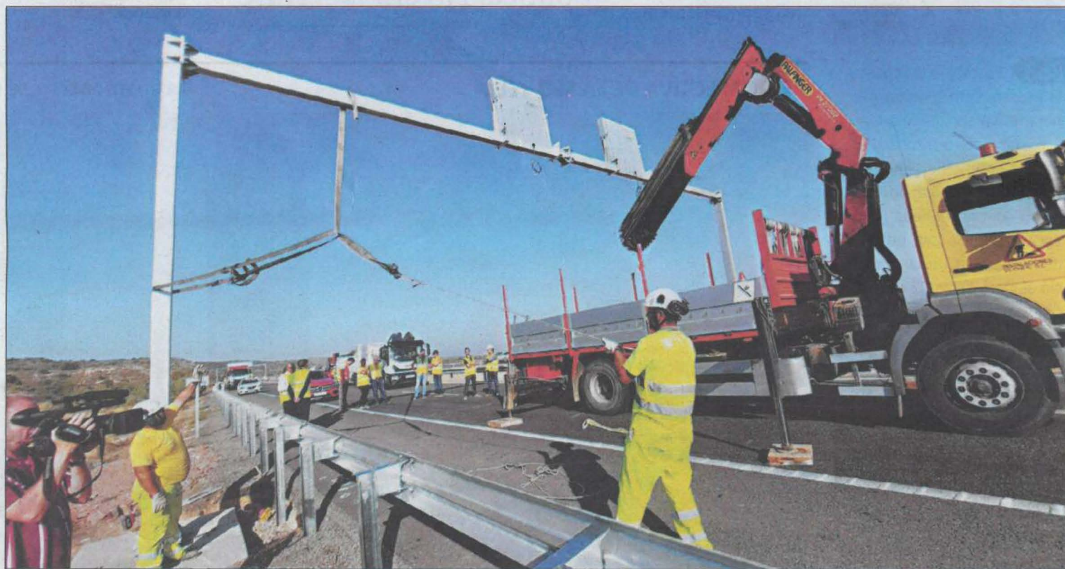
FOTO: Tony Alcántara / Un grupo de operarios trabajando ayer en la instalación de los dispositivos para aumentar la seguridad en la autopista | PÁG. 3
