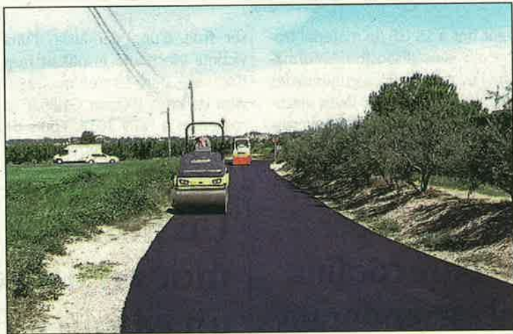
FOTO: Aj. Alpicat/ Els tècnics treballant en la remodelació del camí
