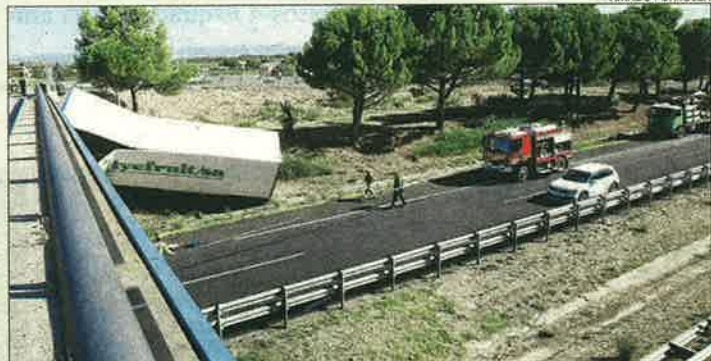
El tràiler va quedar encastat en el pont a l'autovia.
