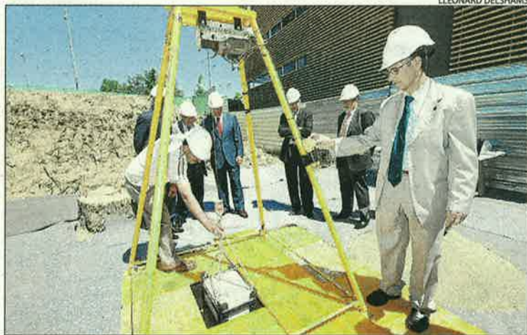
Viñas, en la col·locació de la primera pedra del segon edifici.
