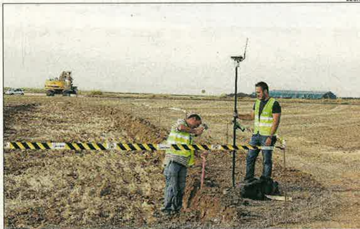
Imatge d'arxiu de la col·locació d'estaques al traçat.
