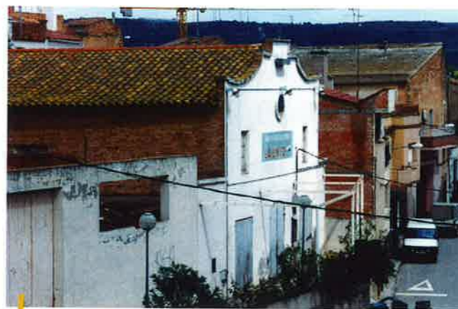
Fig. 7 - Edifici de la Societat La Unió abans de ser enderrocada. Foto: Fabià Corretgé
