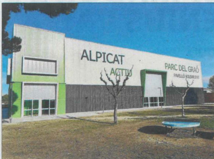
Aspecte exterior del pavelló que s'inaugura avui a Alpicat.
