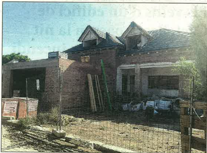
FOTO: Aj.Alpicat / Una casa en construcció a Alpicat
