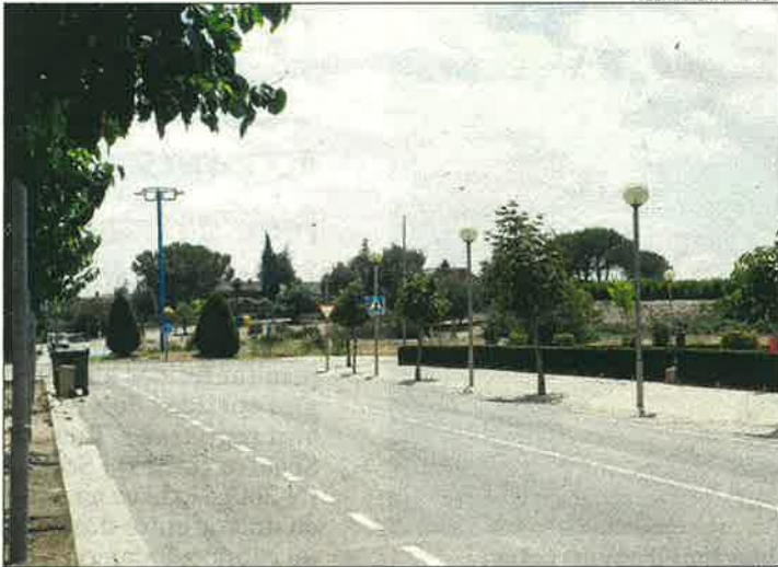
Una de les vies en les quals s'ha substituït l'enllumenat.
