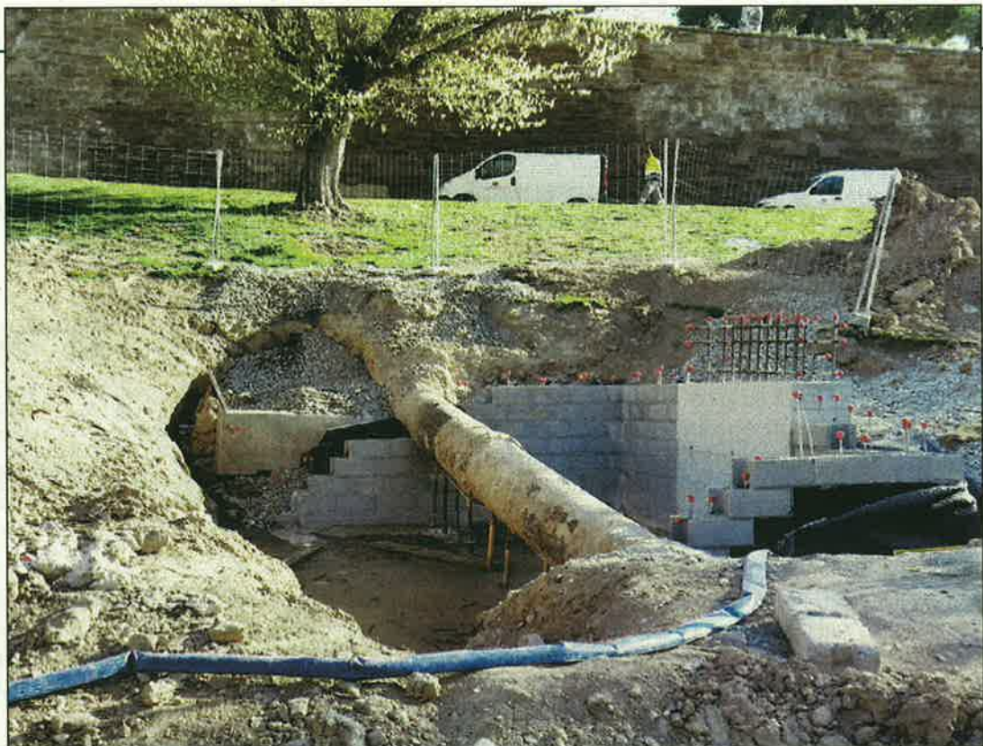
FOTO: Paeria / Los trabajos se alargarán unos 15 días pero no se prevén interrupciones en el servicio
