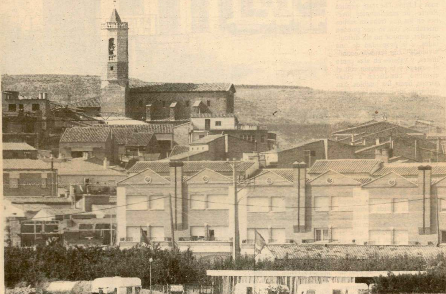
Las nuevas construcciones contrastan con las edificaciones antiguas del casco urbano de Alpicat, uno de los pueblos que ha acogido a más "huidos".
